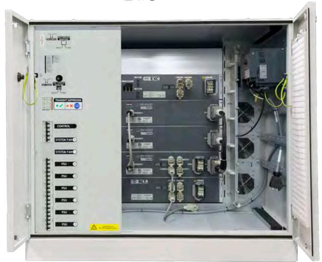
RHINO 和 RLT 电源装置可为汞灯或表面LED提供可靠电源。准分子射线电源箱安装在同一个电柜，整个组合系统由同一个操作屏幕控制，提供方便简洁使用的交钥匙方案。
